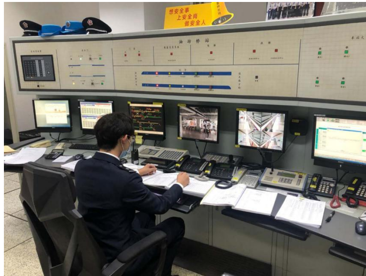
本专业学生在地铁车站顶岗实习
