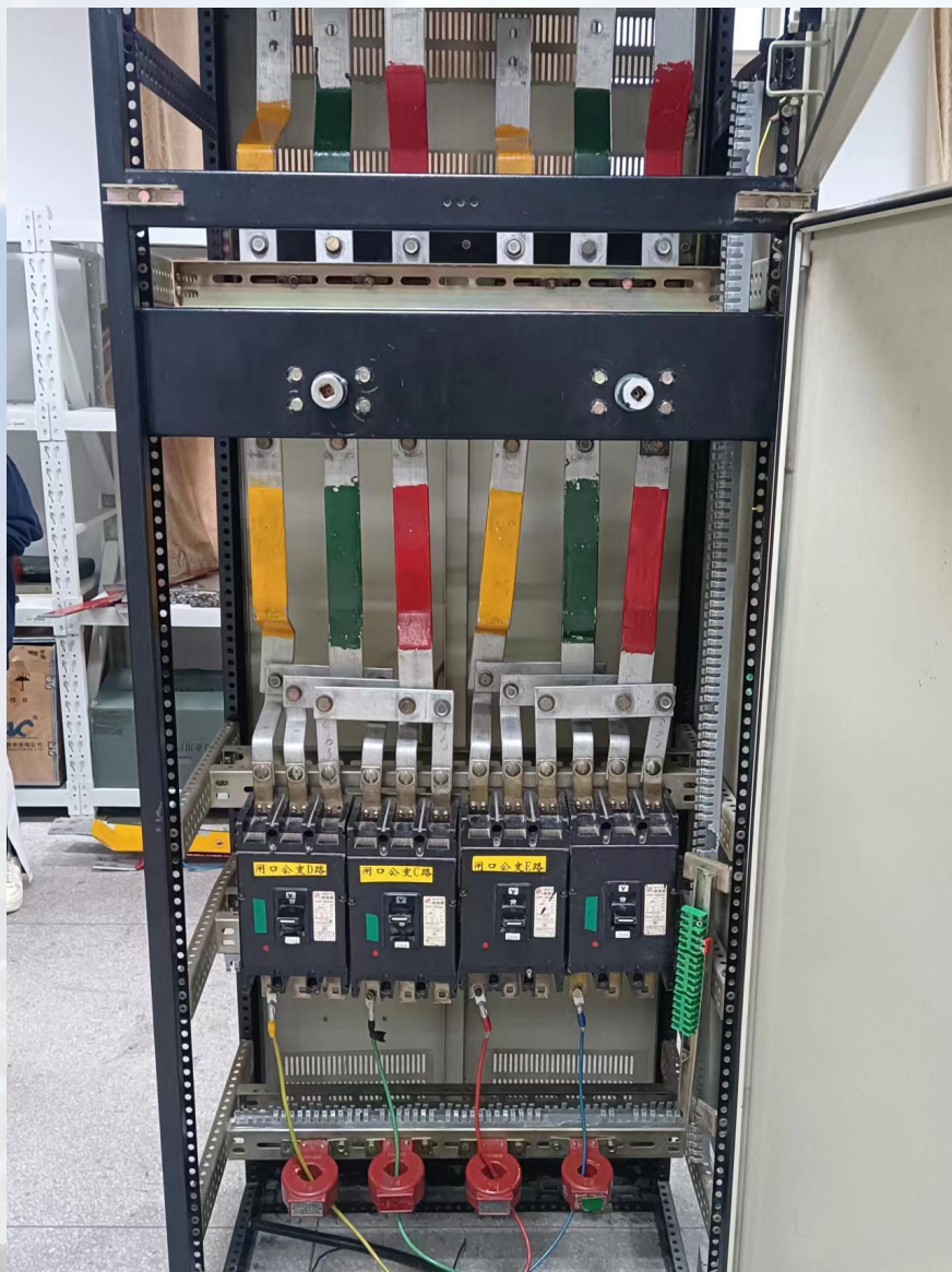
一次设备安装
